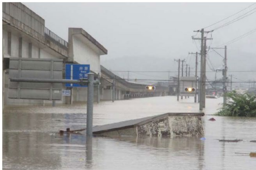
7月7日（土）撮影 左岸0k300付近堤内地
